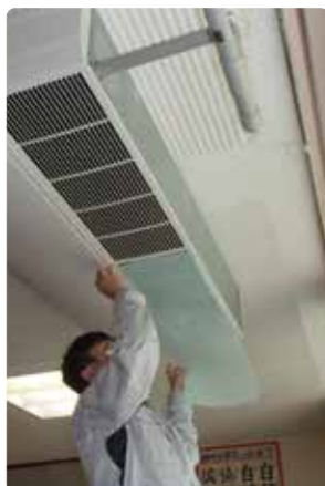
▲エアコンフィルターを取り付ける市職員
