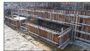
↑ [型枠工事の様子]
