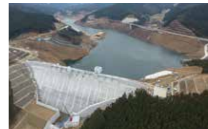
▲完成した伊良原ダム
