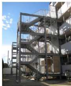
仮設階段設置
