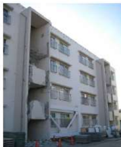
既存階段解体
