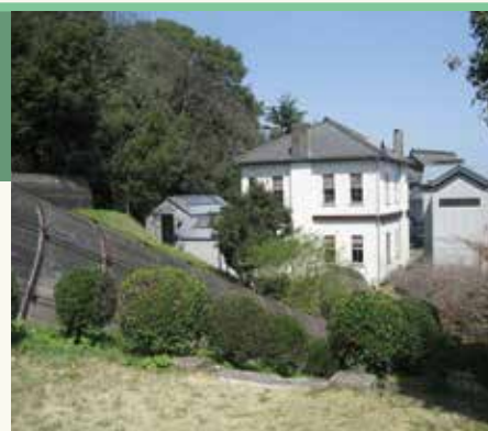
旧筑豊石炭鉱業組合直方会議所 及び救護練習所模擬坑道
