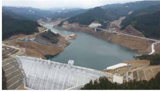
▲半世紀以上をかけて完成した伊良原ダム
