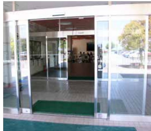
▲玄関の扉を手動から自動に変え、段差をなくしてスムーズな通行を可能にしました
