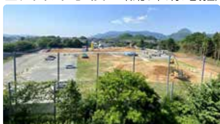
場所：旧伊田中学校敷地内
