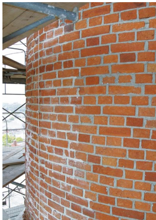
▲修復後の煙突表面（地上約30m）。レンガを入れ替え、目地を修復した（中央から左）。
