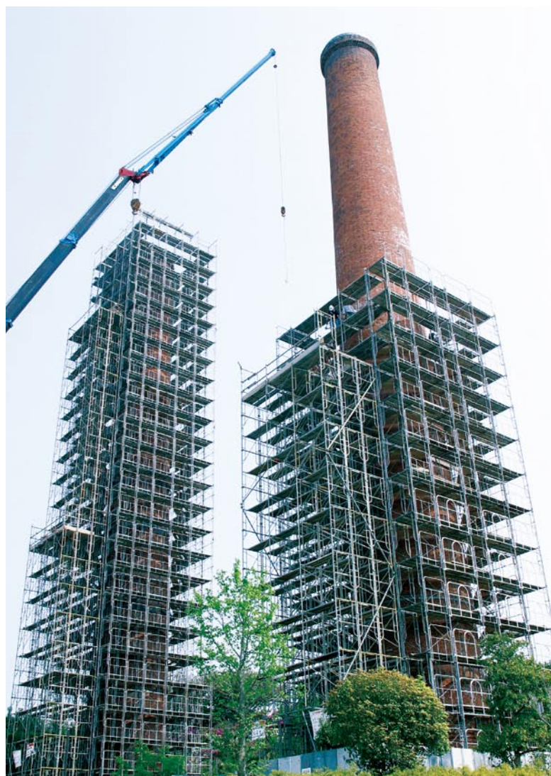
▲足場が撤去され姿を現す二本煙突。その後足場の撤去を終え、5月13日に竣工式が行われた。
