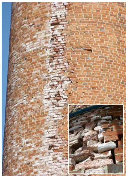
▲修復前の煙突南側表面。目地が消失し、レンガの剥離が起きている。
