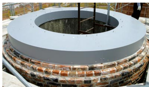
▲修復後の煙突頭頂部。劣化の原因となった雨水の浸入を防ぐため、ステンレス製の覆いを設置
