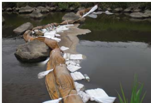
▲油をオイルフェンスで防ぎます
