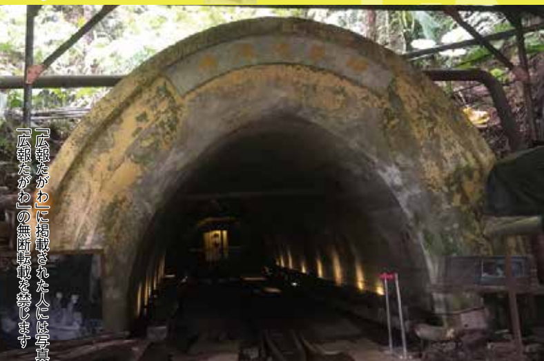
新平溪煤礦博物園區 坑口
